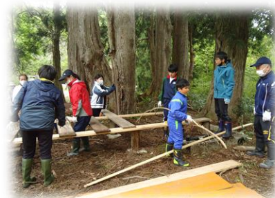
【ロンレー子ども村遊具設置作業】
